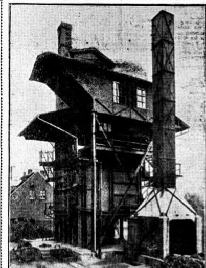
Nueva batería de hornos de gas, de cámaras verticales, con accionamientos mecánicos, del tipo más moderno, adoptado en el extranjero, donde el **servicio de gas** se considera como factor importante de progreso, siendo utilizado casi exclusivamente en todos los usos de calefacción, por su limpieza, higiene y comodidad. ∴ Está en montaje actualmente esta batería, para popularizar el empleo de las **cocinas de gas**, suministrando este fluido en las mejores condiciones de calidad y presión.
